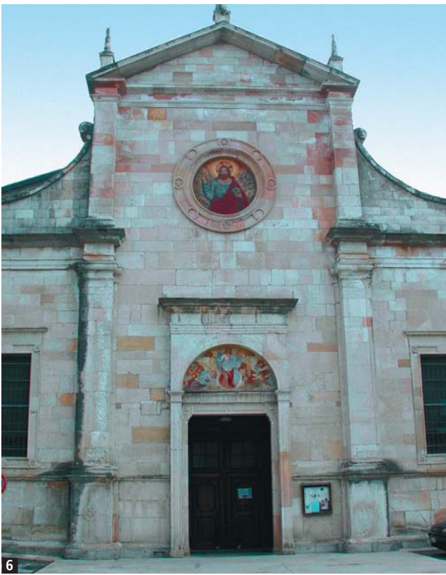
Figura 6 – Facciata della chiesa di Santa Maria ad Angera.
