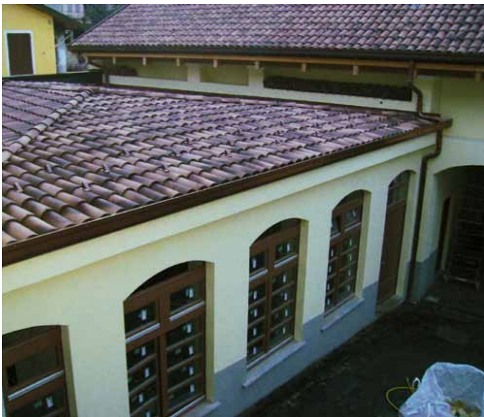
Le facciate esterne dell'Ex Conceria al termine dei lavori di restauro
