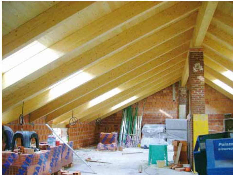
La nuova struttura del tetto in legno
