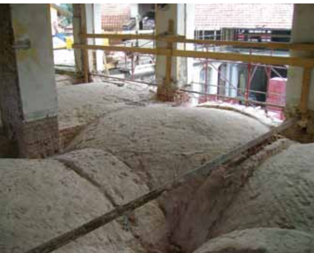
I solai in voltini di laterizio recuperati
