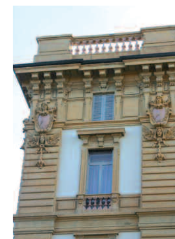
Particolari di decorazioni in intonaco decorativo dopo la pulitura. La raffinatezza del modellato era quasi scomparsa sotto le patine nere causate dallo smog.
