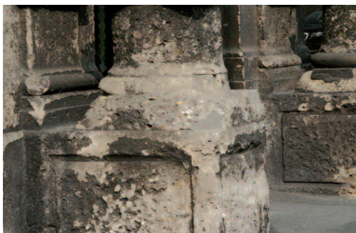
Particolare del basamento in Pietra dell'Adda del piano terra prima dell'intervento.
