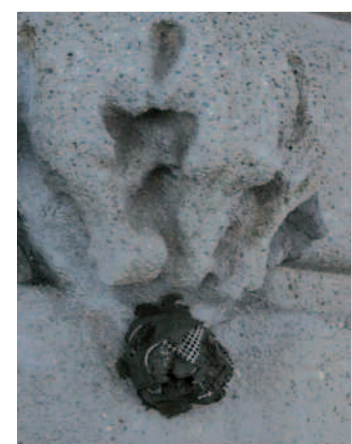
Integrazione armata di una decorazione lesionata.
