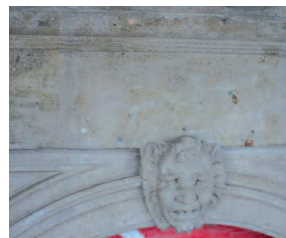
Particolari di decorazioni in intonaco decorativo dopo la pulitura. La raffinatezza del modellato era quasi scomparsa sotto le patine nere causate dallo smog.
