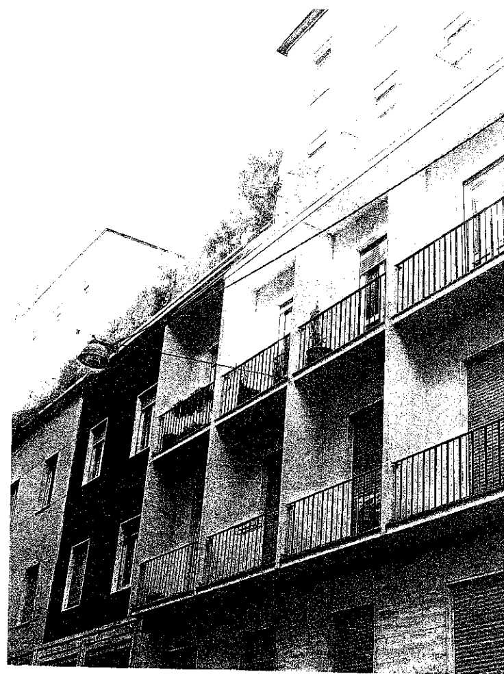
Il rivestimento in piastrelle ceramiche è stato sostituito con un intonaco ai silicati di potassio
