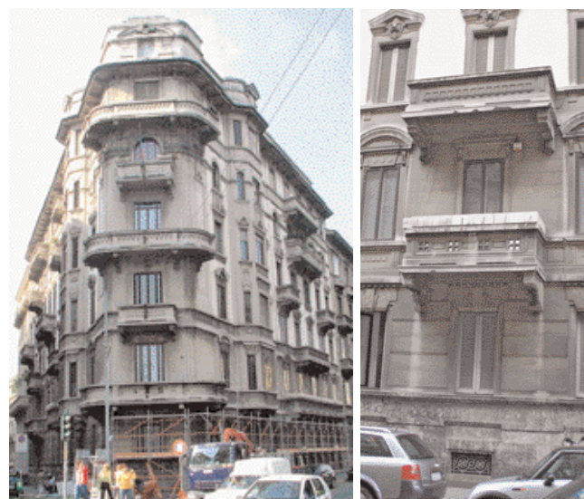
Vista generale del palazzo prima del restauro con particolare dello stato di conservazione delle facciate prima dell'intervento di pulitura.
