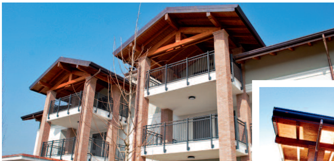
Nella pagina a fianco Virginio Trivella, amministratore della Trivella Spa di Cinisello Balsamo (MI). Nelle altre immagini, interni ed esterni del progetto residenziale TerraCielo Rodano www.trivella.it - www.terrაციelo.biz
